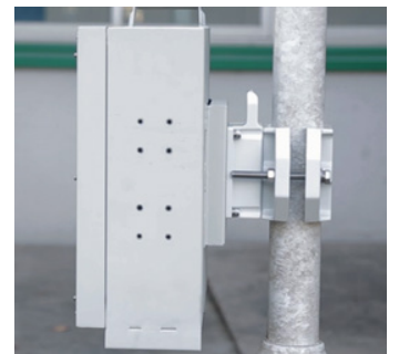
电池安装示意图
